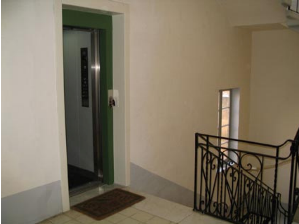
Lift installat fi Strada San Paolo ġewwa l-Belt Valletta
