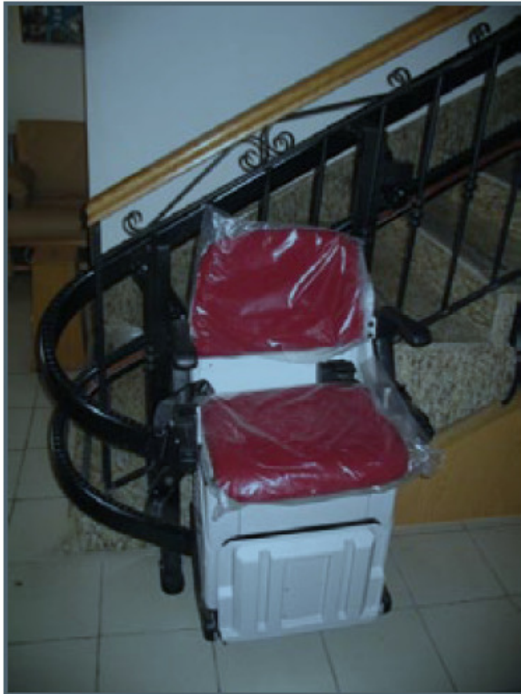
Stair Lift installat taht Skema 7
