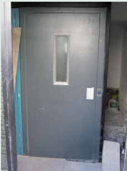
Struttura tal-'lift' maħduma minn materjal tal-aluminjum u hgieg li ġie użat mill-ġdid
