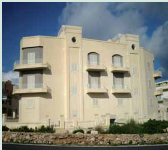
Blokki ta' appartamenti ġewwa il-Mellieħa
