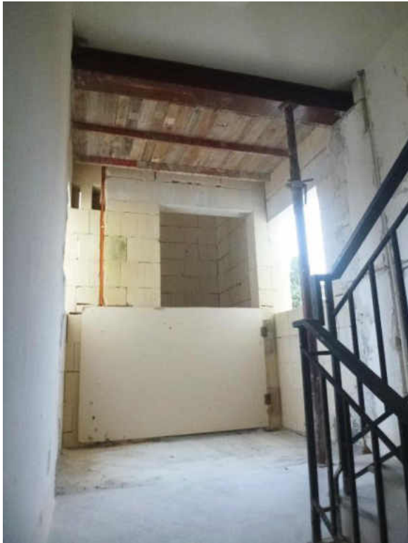
Stampi Nru. 3 u 4 – Xogħlijiet fuq is-sit bi preparazzjoni għall-akkomodazzjoni tal-lift f'estenzjoni mal-komun kif ukoll fl-ispażju ta' bejn it-taraġ
