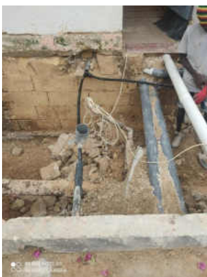
Stampi Nru. 5 – 7 – Alterazzjonijiet neċessarji fis-servizzi li jinstabu waqt l-iskavar. Ritratti juru qabel u wara l-interventi, u l-progress finali tal-kostruzzjoni li setgħet tavvanza bla xkiel.
